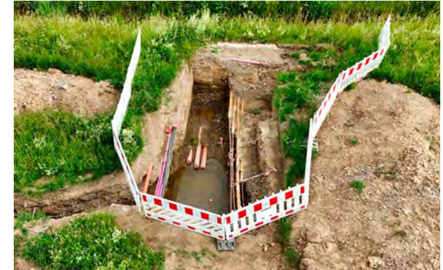
Bild 22.4: Baustelle für die Umsetzung der 10kV-Maßnahme Fig. 22.4: Construction site for the implementation of the 10 kV measure
