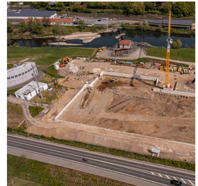
Bild 19.8: Baugrube mit Verbauwand im Mai 2022 Fig. 19.8: Excavation pit with retaining wall in May 2022
