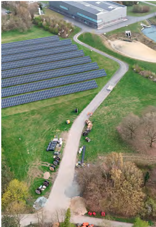
Bild 22.5: Lagerplatz für Stromnetzbetreiber Fig. 22.5: Storage space for the power grid operator
