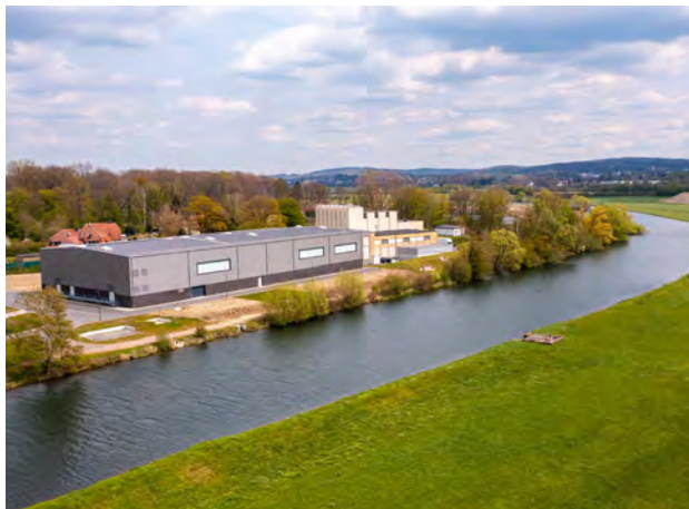
Bild 19.5: Wasserwerk Westhofen mit WAA
