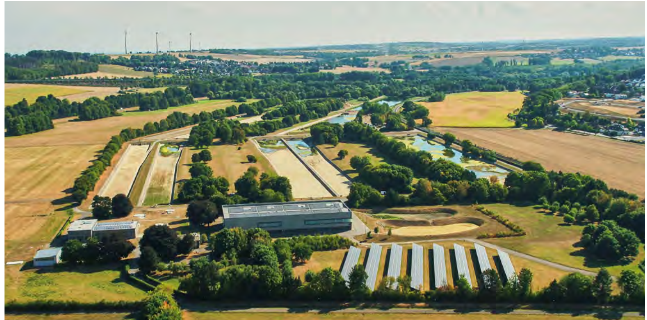
Bild 19.3: Wasserwerk Echthausen mit WAA
