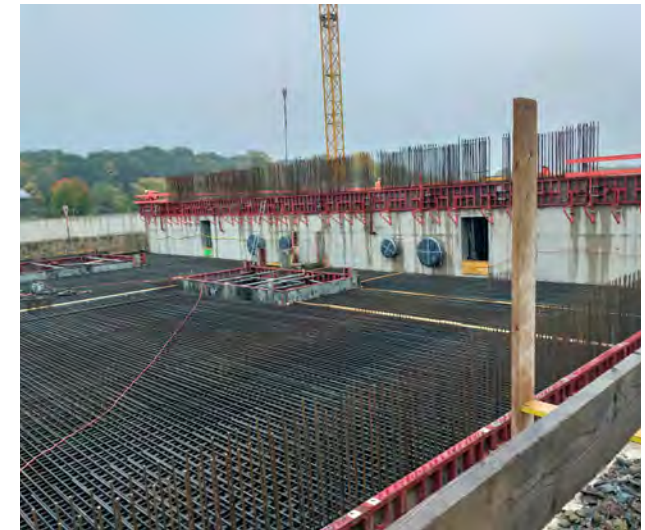
Bild 19.9: Schal- und Bewehrungsarbeiten im Oktober 2022 Fig. 19.9: Formwork and reinforcement works in October 2022
