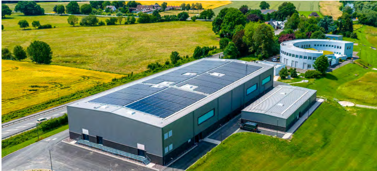
Bild 19.7: Wasserwerk Halingen mit WAA Fig. 19.7: Halingen waterworks with water treatment facility
