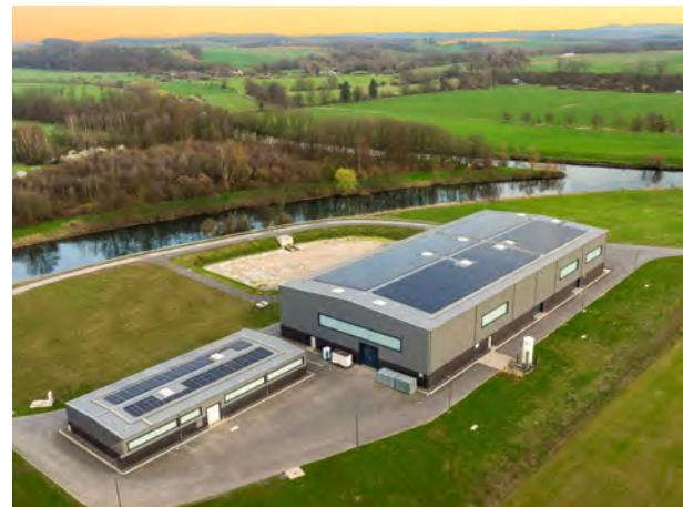
Bild 19.6: Wasserwerk Hengsen mit WAA
