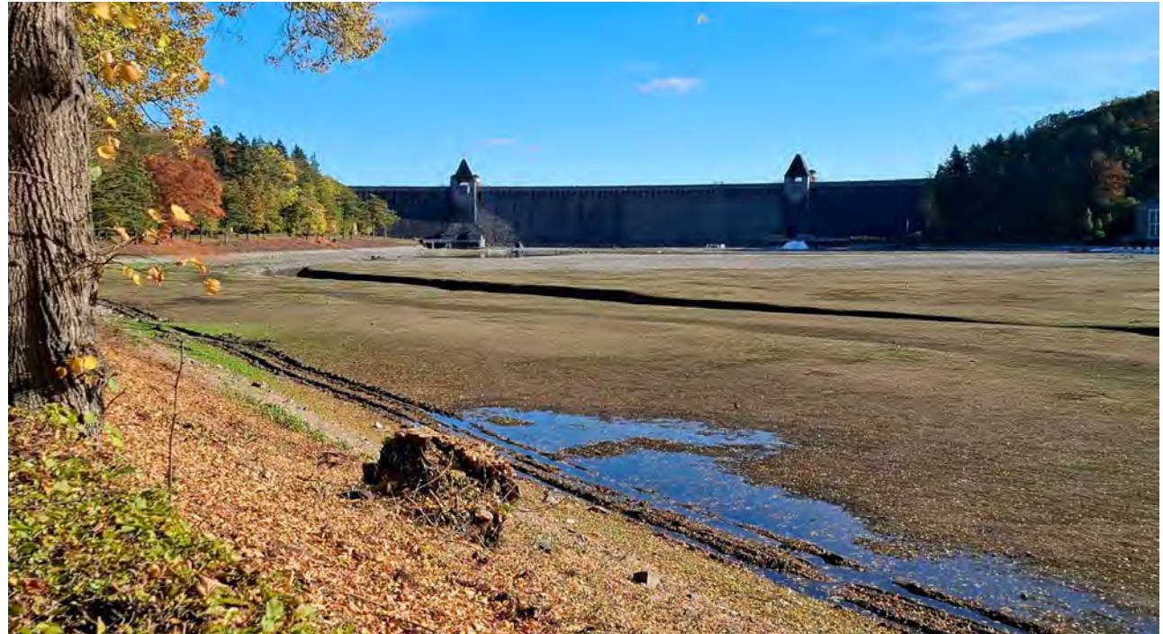
Bild 8.1: Für Instandsetzungsarbeiten wurde der Ausgleichsweiher der Möhnetalsperre im Jahr 2025 mehrmals zeitweise entleert. Fig. 8.1: The compensation pond of the Möhne Reservoir was temporarily drained several times in 2025 to carry out repair works.
