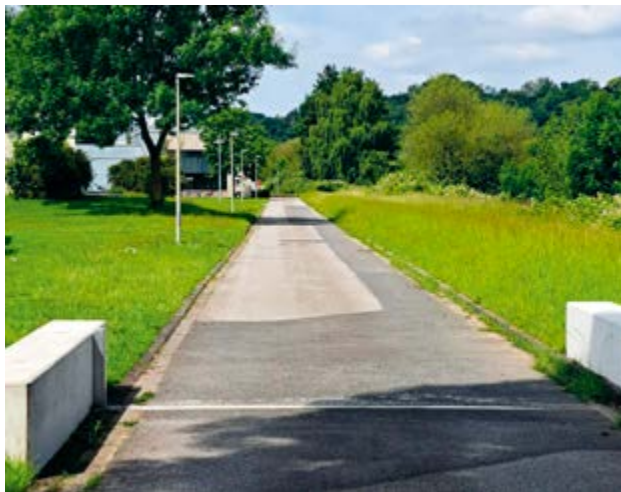
Bild 21.3: Verwallung und Beton-Stirnwände als Hochwasserschutz am Spiek (Juni 2025)
