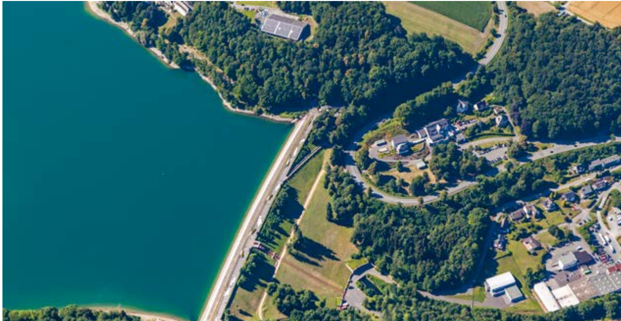
Bild 19.4: Direktentnahme aus der Hennetalsperre zur Trinkwasseraufbereitung von Hochsauerlandwasser in Meschede Fig. 19.4: Direct abstraction from the Henne Reservoir for drinking water treatment by Hochsauerlandwasser in Meschede
