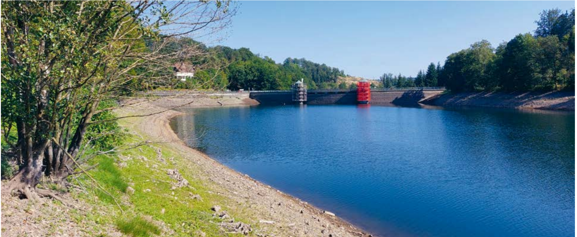
Bild 8.2: Fürwiggetalsperre mit niedrigem Wasserstand aufgrund der im Sommer 2024 durchgeführten Sanierungsarbeiten an Teilen der Staumauer. Fig. 8.2: Fürwigge Reservoir with low water level due to renovation work on parts of the dam carried out in summer 2024.
