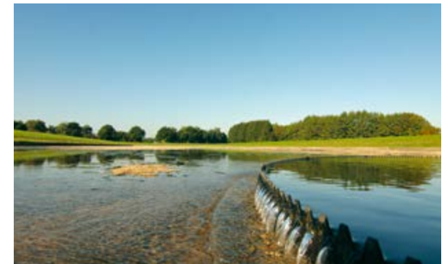
Bild 19.3: Grundwasseranreicherung von Ruhrwasser durch Langsandsandfilter im Wasserwerk Hengsen von Wasserwerke Westfalen Fig. 19.3: Groundwater enrichment of Ruhr water through slow sand filtration at the Hengsen waterworks of Wasserwerke Westfalen
