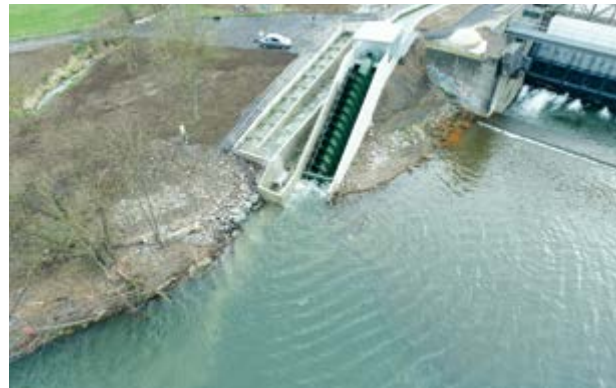
Bild 19.6: Laufwasserkraftschnecke und Fischtreppe am Wehr Schwitten der Stadtwerke Fröndenberg Wickede GmbH Fig. 19.6: Archimedean screw turbine and fish ladder at the Schwitten weir operated by Stadtwerke Fröndenberg Wickede GmbH
