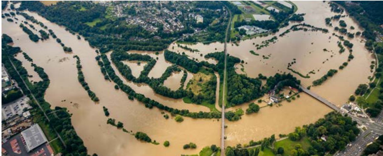
Bild 19.7: Extremhochwasser am 15. Juli 2021, Wassergewinnung Essen-Überruhr Fig. 19.7: Extreme flooding on 15 July 2021, Wassergewinnung Essen-Überruhr
