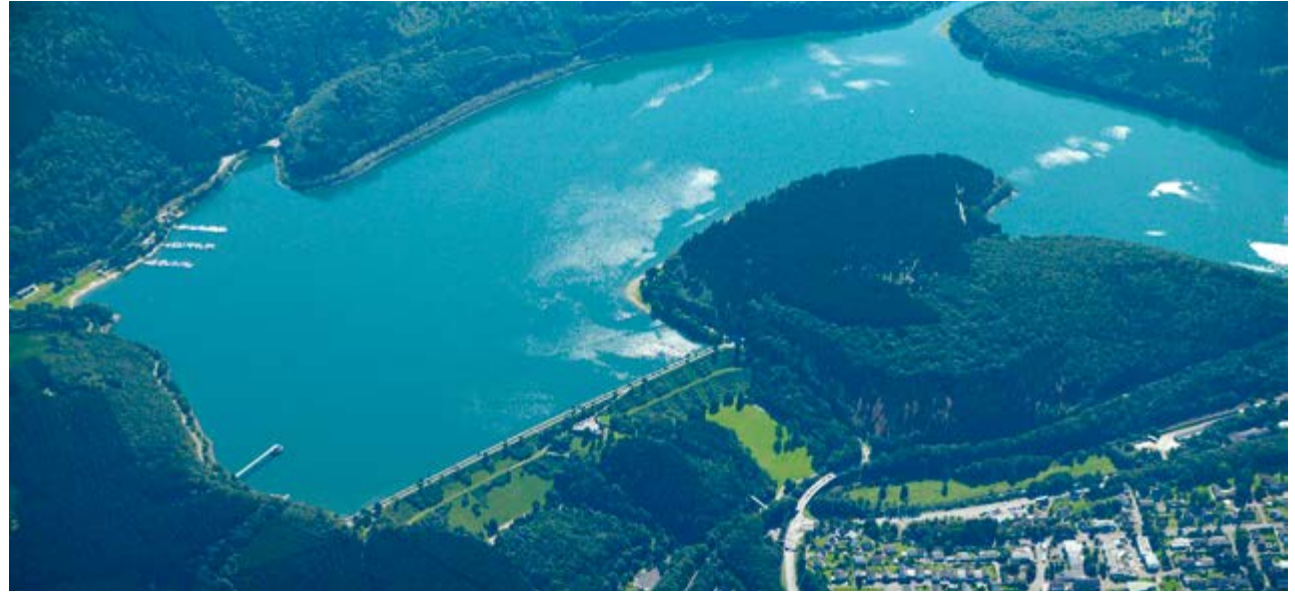
Bild 19.2: Talsperren, Ruhr und Wasserwerke sind grundsätzlich ein resilientes Versorgungssystem im Klimawandel Fig. 19.2: Reservoirs, the Ruhr and waterworks form a fundamentally resilient supply system in the face of climate change.
