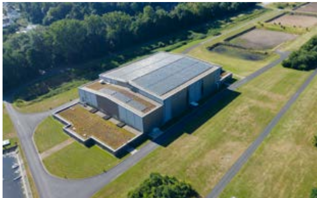
Bild 19.5: Großtechnische weitergehende Wasseraufbereitungsanlage der Wassergewinnung Essen Fig. 19.5: Large-scale advanced water treatment plant of Wassergewinnung Essen
