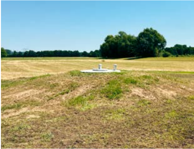
Bild 19.1: Erneuerung und Ausbau der Trinkwasseranlagen ist sehr kostenintensiv wie hier der Bau neuer Fassungsbrunnen im Wasserwerk Hengsen der Wasserwerke Westfalen GmbH. Fig. 19.1: Modernisation and expansion of drinking water facilities involves high costs, as illustrated by the construction of new intake wells at the Hengsen waterworks of Wasserwerke Westfalen GmbH.
