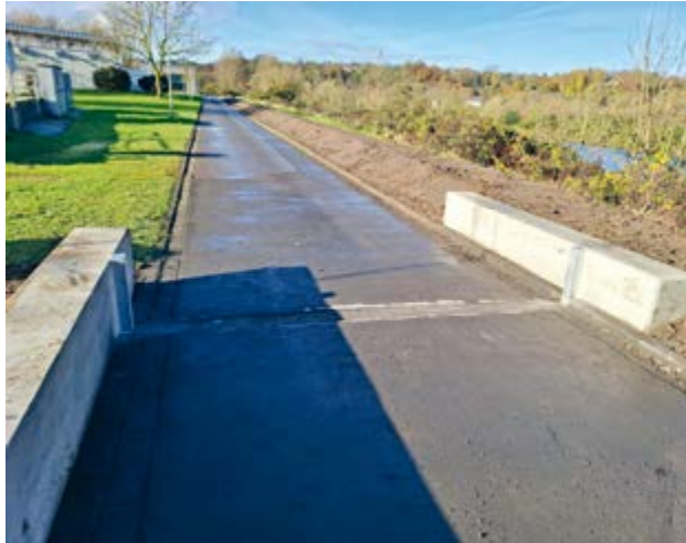
Bild 21.2: Verwallung und Beton-Stirnwände als Hochwasserschutz am Spiek (Nov. 2024)
