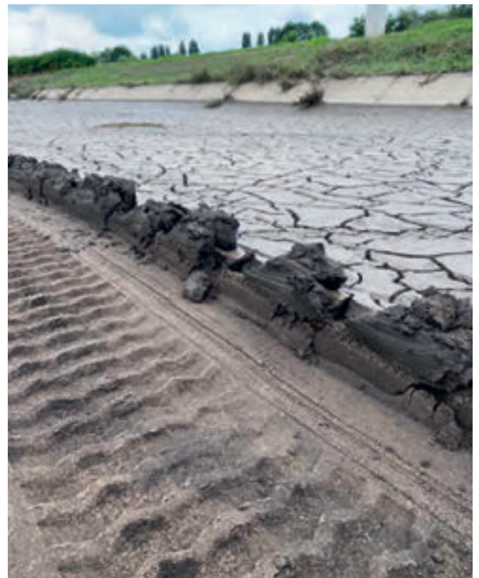
Bild 17.3: Filterbecken mit Schlammablagerung oberhalb des Filtersands im Wasserwerk Mülheim-Styrum/Ost (RWW) Fig. 17.3: Filter tank with landfilling above the filter sand at the waterworks Mülheim-Styrum/Ost (RWW)
