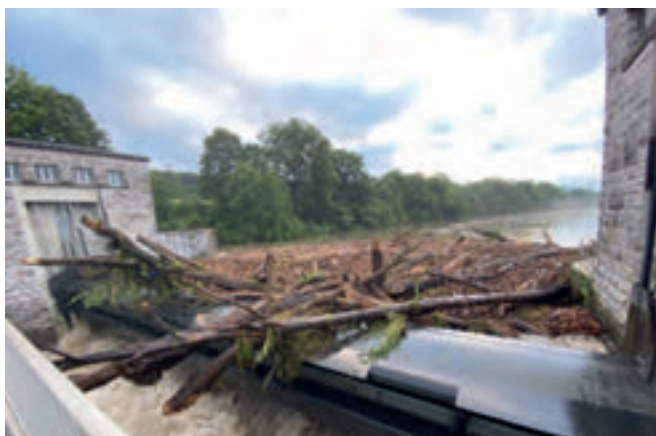
Bild 17.1: Ansammlung von Treibgut an der Wehrklappe des Wasserkraftwerks Echthausen (WWW) Fig. 17.1: Flotsam accumulating at the weir gate of the hydropower station Echthausen (WWW)
