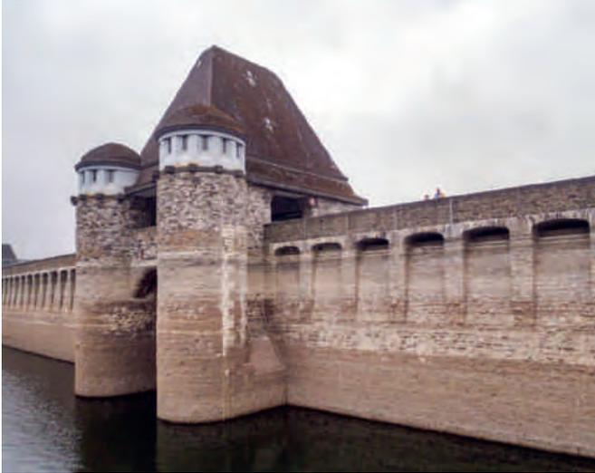
Bild 8.2: Abgesenkte Möhnetalsperre – Pegellatte an der Mauer
