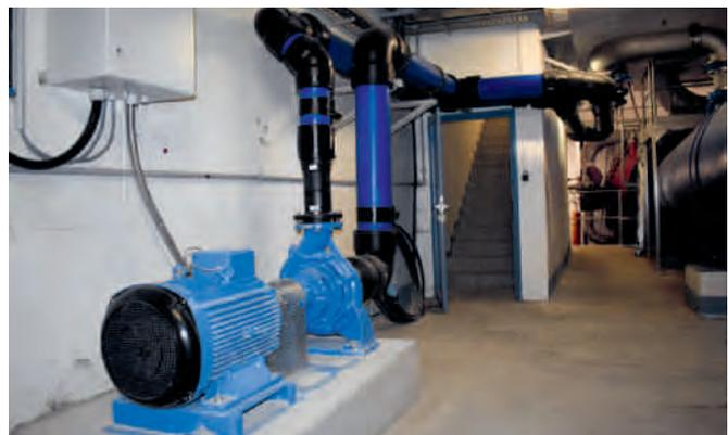
Bild 17.3: Einbau einer Druckerhöhungspumpe im Grundablassbauwerk der Hennetalsperre
