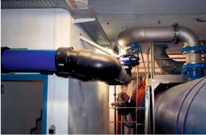
Bild 17.2: Installation einer Bypass-Leitung im Grundablassbauwerk der Hennetalsperre
