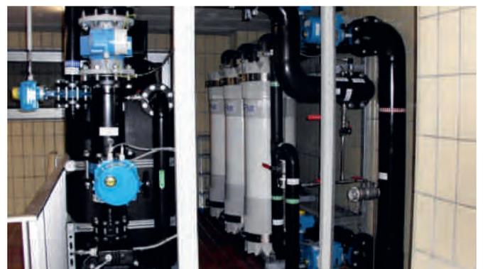
Bild 20.2: Neue Membranfilteranlage (Ultrafiltration) im Hochbehälter Bremberg
