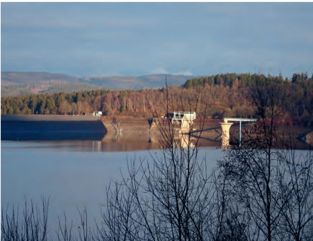
Bild 6.9: Hochwasserentlastung der Biggetalsperre in 15 Metern Höhe über dem Wasserspiegel
