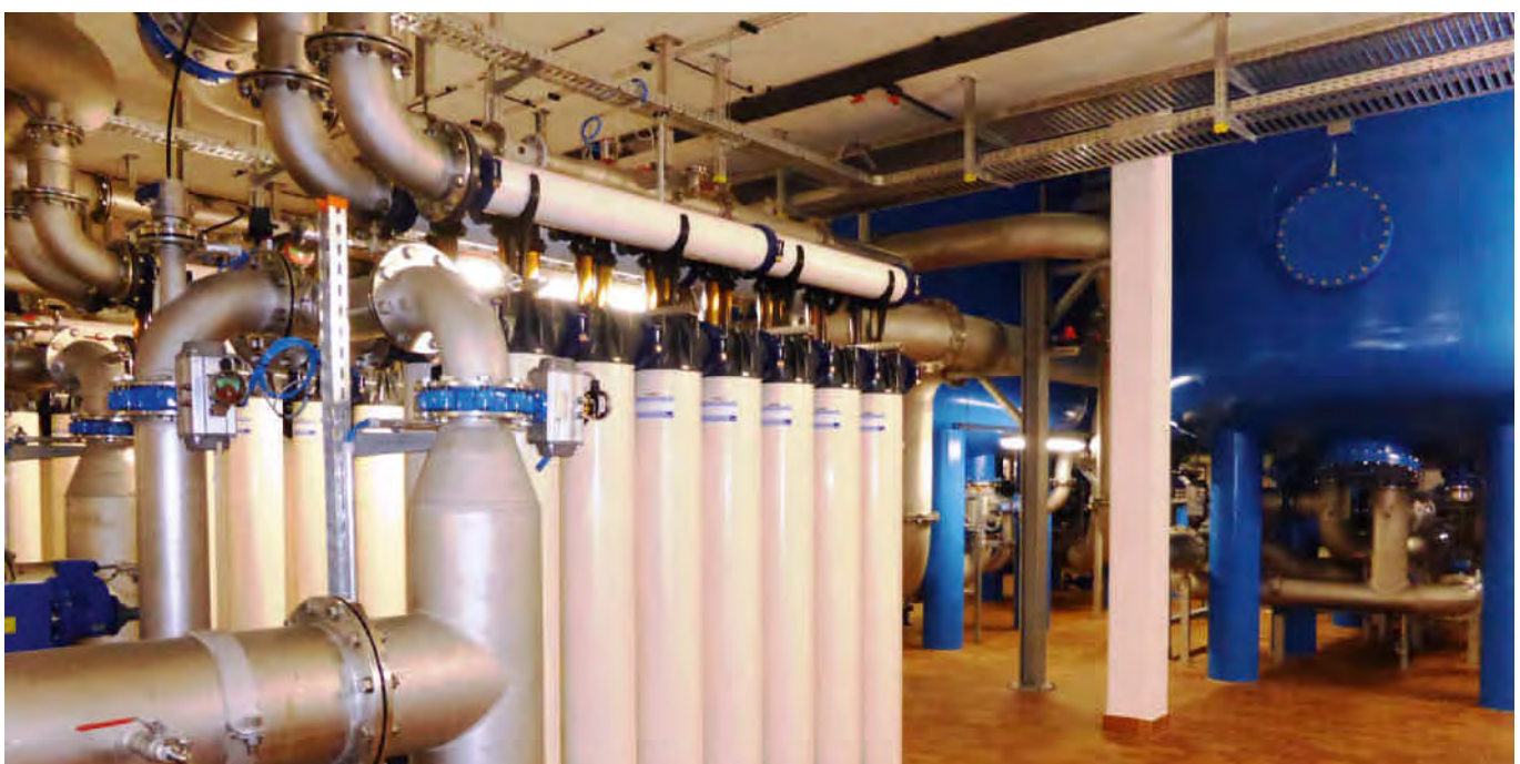
Bild 16.2: Ultrafiltrationsmembranmodule im WW Hennesee Fig. 16.2: Ultrafiltration membrane module at the waterworks Lake Henne
