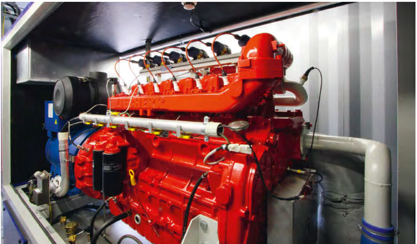
Bild 12.9: Insgesamt 52 Blockheizkraftwerke wie dieses auf der Kläranlage Sundern helfen dem Ruhrverband dabei, seinen Energiebezug zu senken Fig. 12.9: A total of 52 small power units like this one at the wastewater treatment plant in Sundern reduce the Ruhrverband's demand for external energy supply
